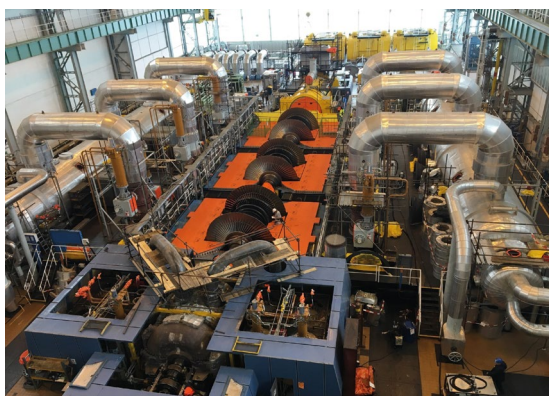
Mezi důležité činnosti odstávek patří i kontroly turbíny.
