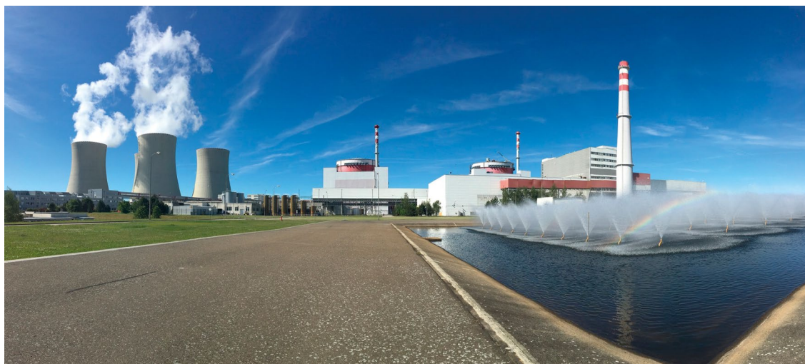
Bazény technické vody jsou důležitou součástí klíčových bezpečnostních systémů. Foto: Archiv JE Temelín
