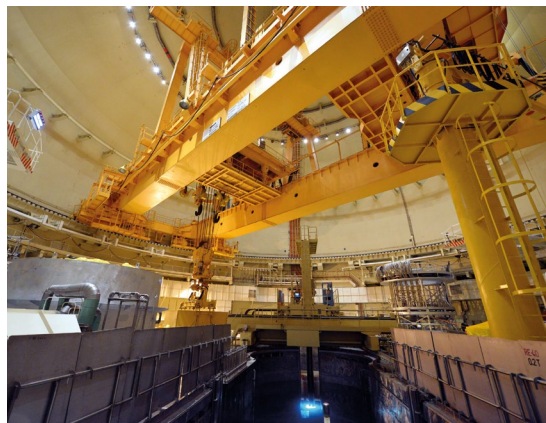
Během odstávky energetici vymění přibližně čtvrtinu paliva. Foto: Archiv JE Temelín
