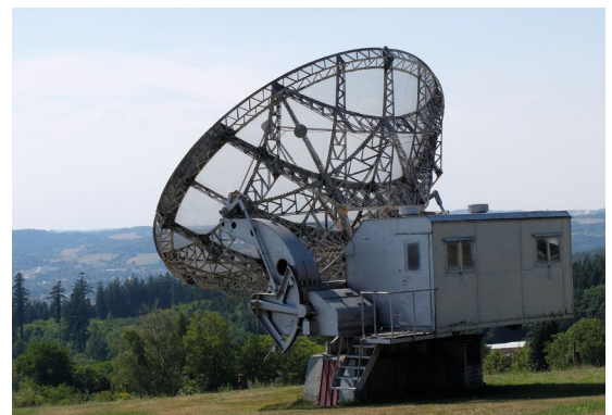
Jedna ze dvou historických antén v areálu Ondřejovské hvězdárny. (Byly to radary typu FuMG-65 Würzburg-Riese z druhé světové války). Foto: J. Žďárská
