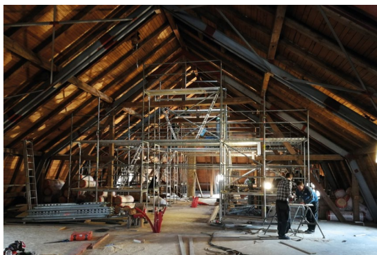
Obr. 3 „Pravidla dotace neumožňovala změnu vnějšího pláště budovy, byly tedy maximálně využity dříve opomíjené půdní prostory,“ vysvětluje Tomáš Gráf.
