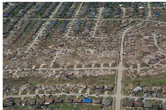
Obr. 2 Škody způsobené tornádem na předměstí Oklahoma City 20. května 2013. Kredit: TSgt Bradley Church
