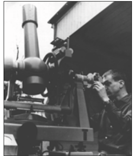
Pozorování pasážíkem Zeiss 100/1000 na Geodetické observatoři Pecný v roce 1963
