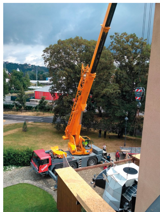
Obr. 8 Když byl vzletový modul hotov, byla odstraněna střecha přístěnku a na spodní část modulu jej přenesl jeřáb. Foto: Archiv Planetum
