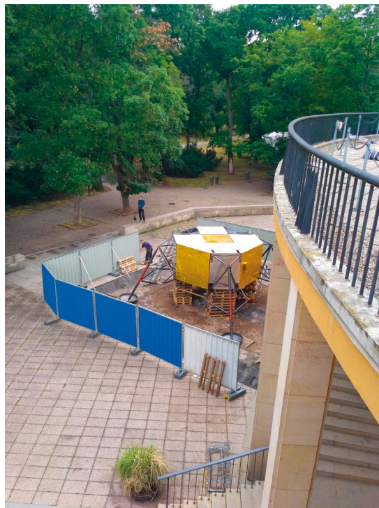
Obr. 5 Spodní část modulu tvoří čtyři kvádry a na nich jsou usazeny čtyři trojúhelníkové konstrukce, které se svařovaly až přímo před budovou. Foto: Archiv Planetum
