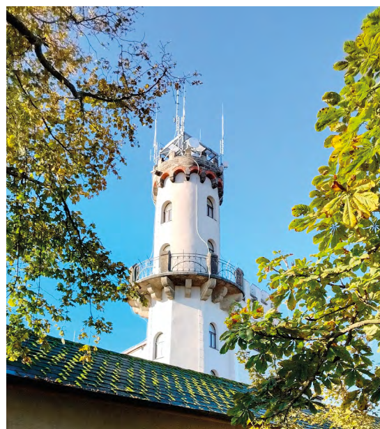
Obr. 4 Opravená věž observatoře na jaře 2025. Autor: Tomáš Plocek
